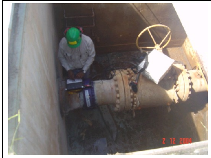
Figura 4. Wavemaker G3 in azione. Test su tuberia interrata a partire da una sezione di tubazione accessibile.
