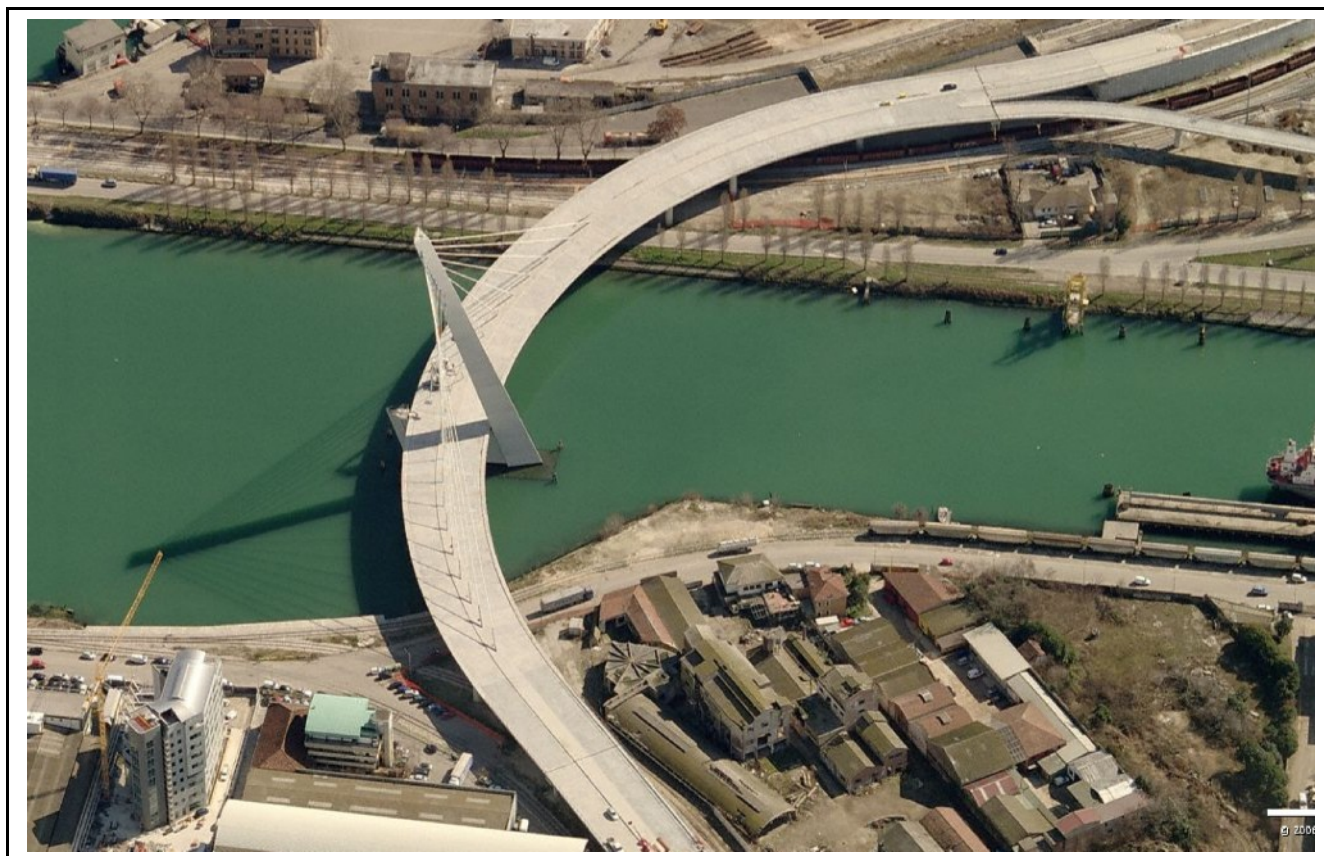
Figura 1 – Vista aerea del ponte
