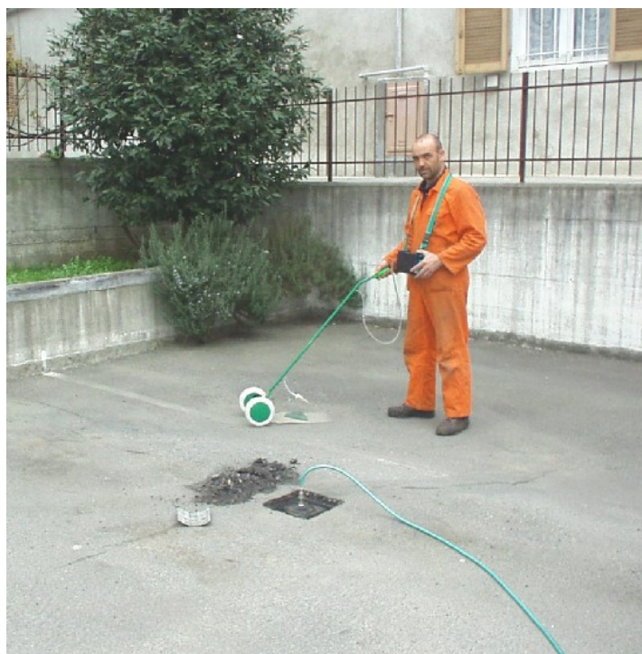
Ricerca di fessurazione della guaina impermeabilizzante con gas tracciante
