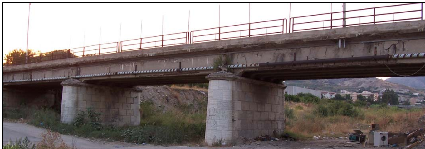
Figura 1: Vista del ponte
