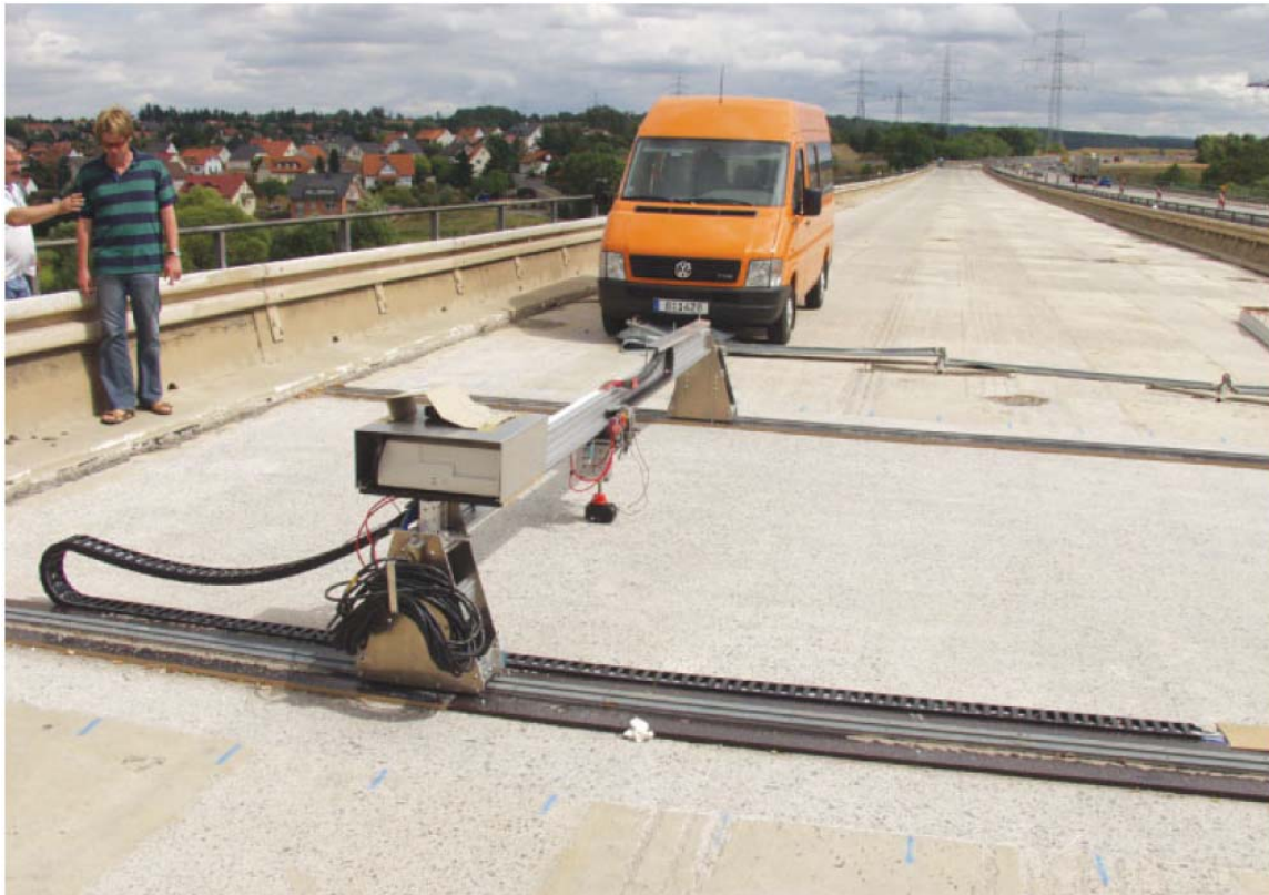
Abbildung 1: Automatisiertes Scannersystem auf einer Fahrbahnplatte (Quelle: Beton- und Stahlbetonbau 100 (2005) [4])
