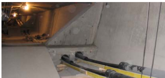
Abbildung 2: Externe Spannglieder: Einbau (links) und Verlauf im Randfeld (rechts)
