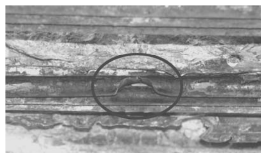
Mit Korrosionszelle erzeugter Drahtbruch
