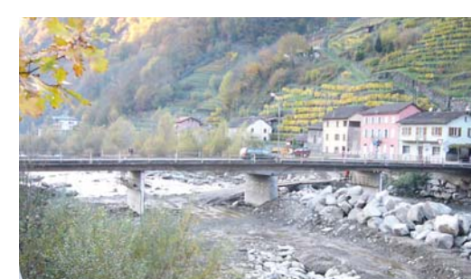
Hilfspfeiler als sichernde Sofortmassnahme
