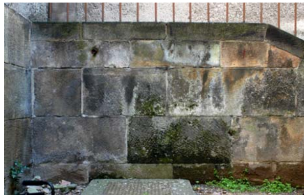
Abb. 4: Geschädigte Sandsteinwand
