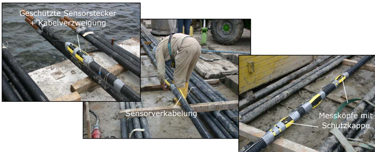
Abb. 6: Fixierung von Funktionsmustern einer pH-Optode auf der ersten Ankerkorrosionsschutzschicht
