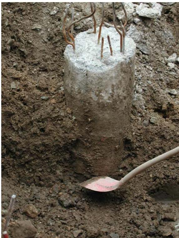
**Bild 5** Beim Abriss beschädigter Pfahl. Die Schaufel steckt in einem bei der Integritätsprüfung erkannten durchgehenden Riss (Foto: BAM)
