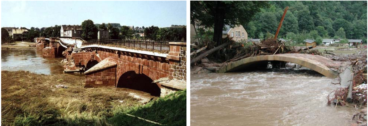
Abbildung 1 und 2: Hochwasserschäden in Sachsen
