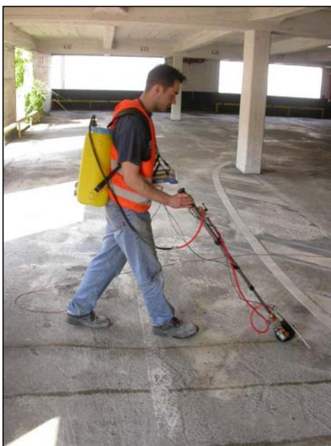
Bild 5: Potentialmessung in einem Parkhaus mit einer Einzelradelektrode
