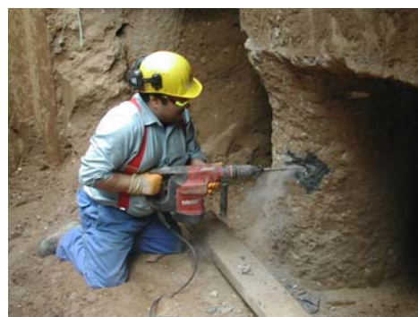
Bild 11 : Herstellen der Prüfmöglichkeit bei zerstörungsfreier Pfahlprüfung
