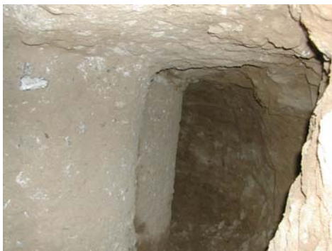
Bild 10 : Beim Freigraben entdeckter Zusatzpfahl
