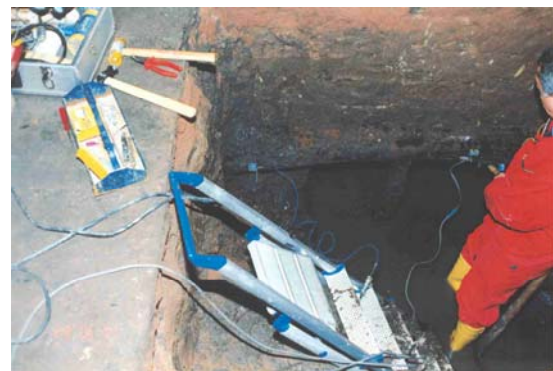
Bild 4 : Messtrecke am Horizontalbalken
