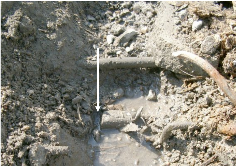
Abb. 8: Das aufgetrennte Spannglied in der Brückenplatte (Pfeil)
