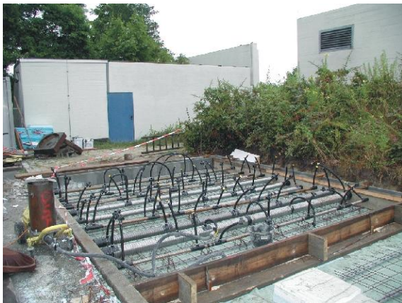
Bild 7 Großer Betonprobekörper der BAM während des Verpressens der Hüllrohre.
