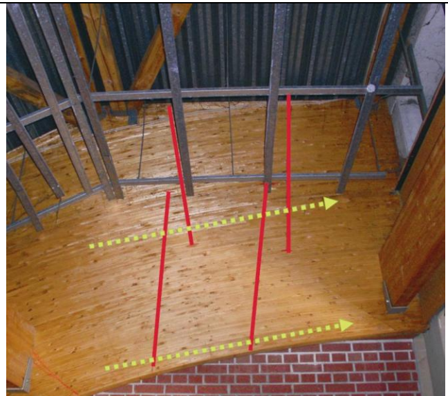
Abbildung 9: Lage der Gewindestangen (rote Linien) und Messspuren (gepunktete Linien)
