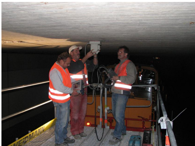
Abbildung 2. Ortung von Verdrängungskörpern in einer Brücke über einer Bahnlinie
