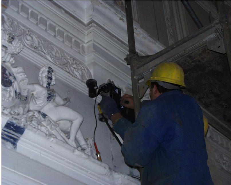
Abbildung 3. Ortung von Lüftungskanälen und Schichtgrenzen im Mauerwerk auf einer denkmalgeschützten Stuckfläche
