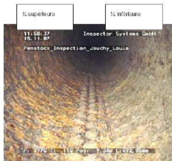
Figure 13 : inspection télévisuelle d'une conduite forcée à l'aide d'un « crawler » d'Inspector systems – visualisation des lignes de rivet
