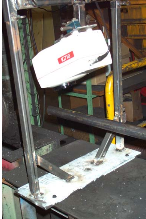
Figure 4 : Installation du capteur chez V&M
