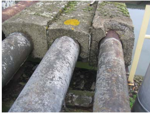
Figure 9 – Tuyauteries noyées dans un fourreau en béton examinée par GWUT
