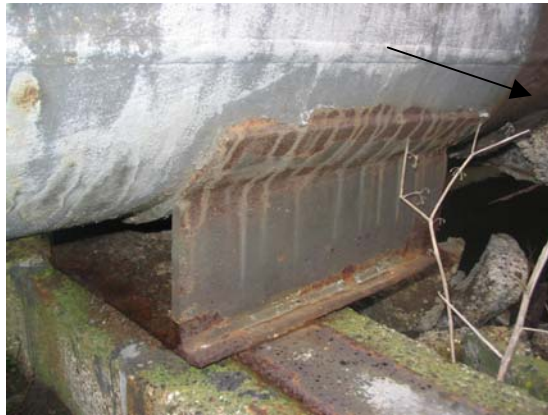
Figure 13 – Corrosion externe à proximité d'un support soudé
