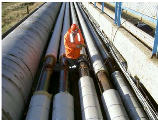
Figure 11 – Inspection GWUT sur des lignes en caniveau
