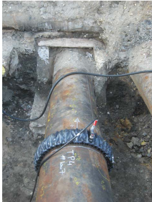
Figure 15 – Anneau souple pour l'inspection d'un tube de diamètre 30"
