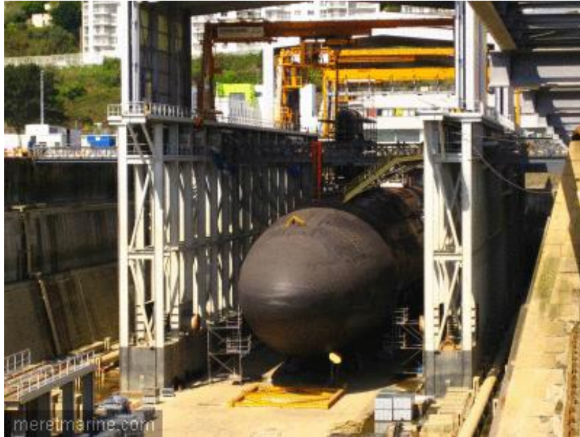
Figure 1 : Sous marin en bassin
