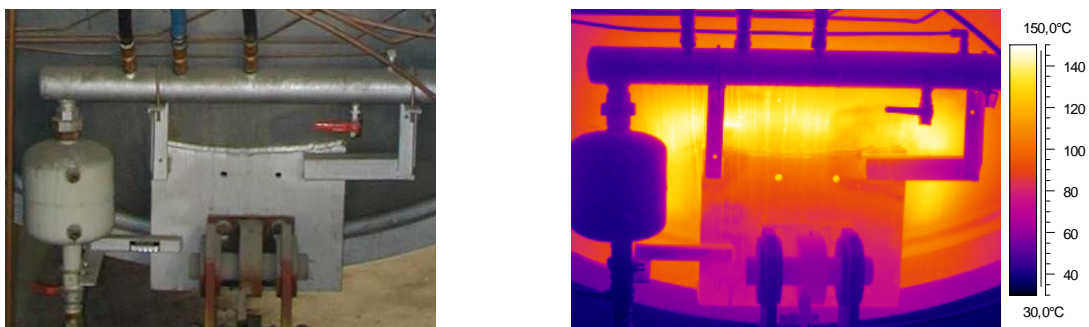
Figure 1 : Contrôle de défaut de calorifuge par thermographie sur un équipement sous pression (CETIM)
