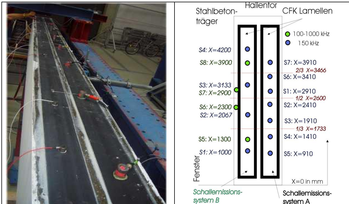
Abbildung 5: Positionen von Sensoren der Schallemissionssysteme A und B auf dem mit CFK-Lamellen verstärkten Stahlbetonträger 5200 mm x 500 mm x 300 mm.
