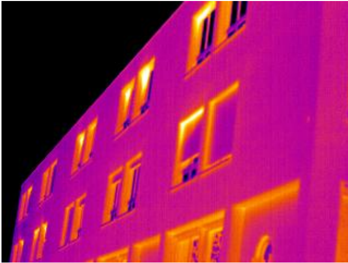
Bild 1: Offen stehende Fenster und voll aufgedrehte Heizkörper sind in Altenheimen häufig die Ursache Nr.1 für enorme Energiekosten. Die einwandfreie Ausführung des WDVS ist gut zu erkennen.
