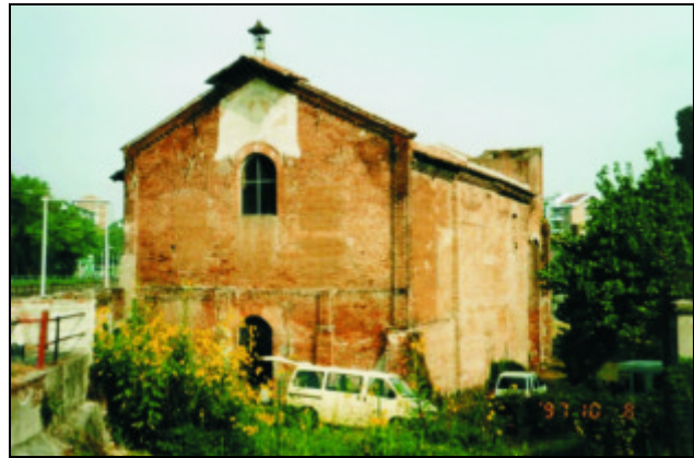
Abbildung 13: Südwestliche Ansicht der Kirche S. Maria Rossa in Mailand, Italien
