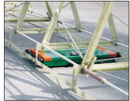
Bild 1: Messung der Dübellagen im Frischbeton mit dem MIT-SCAN 2F unmittelbar hinter dem Fertiger
