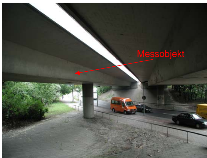
Abb. 5: links: Messobjekt für IE-Messungen: Hohlkastensteg einer Autobahnbrücke aus Spannbeton unter laufendem Verkehr, rechts: Impact-Echo-Messkopf der Firma Olson Instruments, bestehend aus Sensor (1) und Impactor (2)
