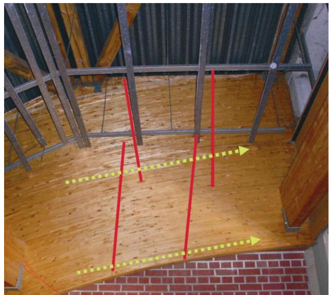
Abbildung 3: Lage der Gewindestangen (rote Linien) und Messspuren (gepunktete Linien)
