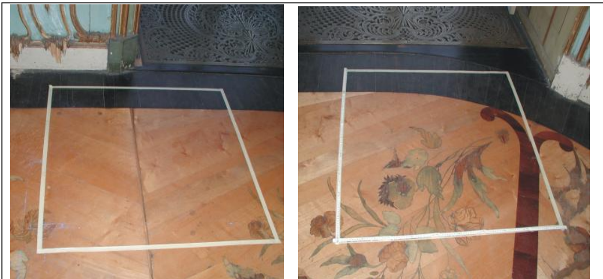
Abbildung 10: Fotos der Thermografiemessbereiche, linke M3, rechts M4
