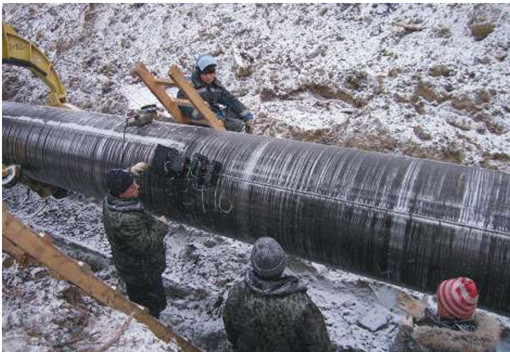
Abbildung 2: Scanner-Roboter "Autokon-MGTU" im Einsatz in Sibirien: Typische Prüfumgebung
