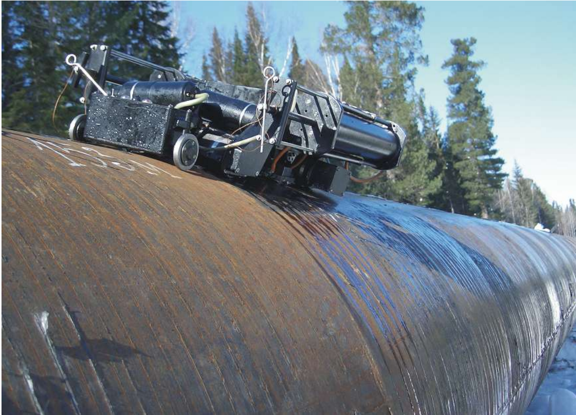
Abbildung 3: Scanner-Roboter “Autokon-MGTU“ im Einsatz in Sibirien: Bei Minus-Temperaturen kann es zu Ankoppelproblemen kommen.
