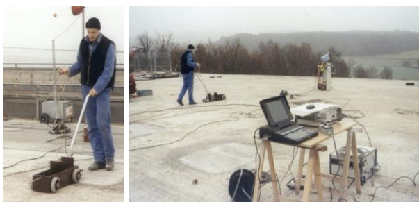
Abb. 5: Messung des Streufeldes einer Brückenplatte in den Neunziger Jahren [TU Berlin, Fachgebiet Baustoffe und Baustoffprüfung]
