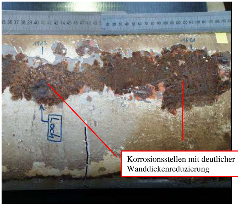
Abbildung 2.5 Rohr 2, Position 1350-1750mm
