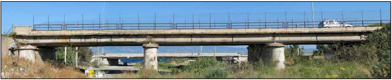
Fig.1 - The Fiumarella bridge
