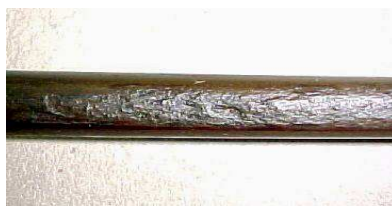
Figura 8: varilla con corrosión incipiente.
